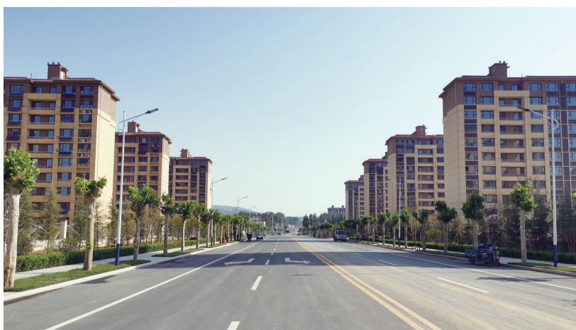
■旧县乡时代新城社区道路完成改造提升。 通讯员供图
