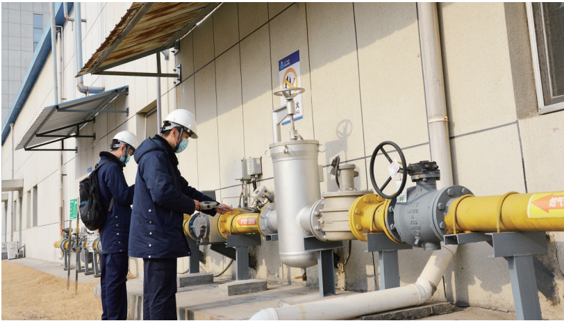
■深入企业检查燃气管线。
