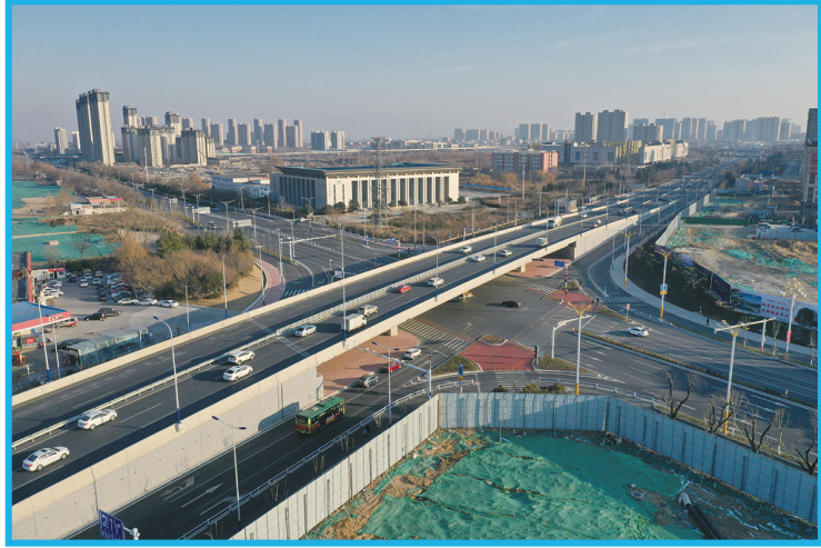
长城路与岱阳大街立交桥。
