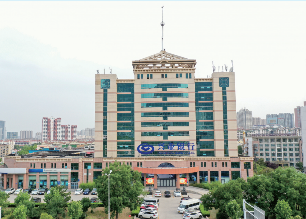
兴业银行泰安分行位于东岳大街460号的办公大楼于2021年初完成装修升级改造。
