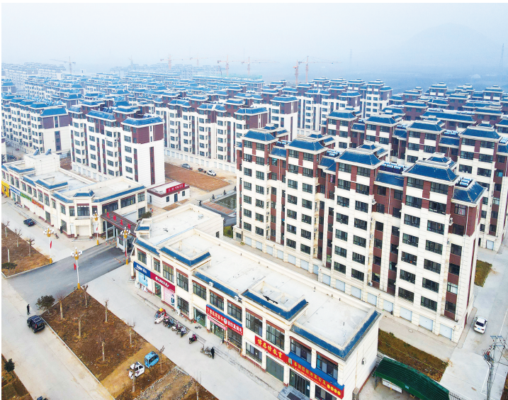
潮泉镇潮泉社区大张庄村集中安置项目。
