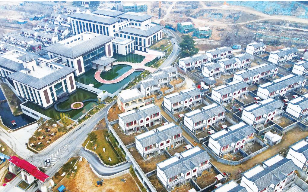
潮泉镇的泰山·桃花源颐养项目正在建设中。
