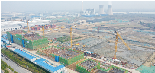
机械工业出版社泰安物流产业园及数码印刷基地建设工程项目现场。
