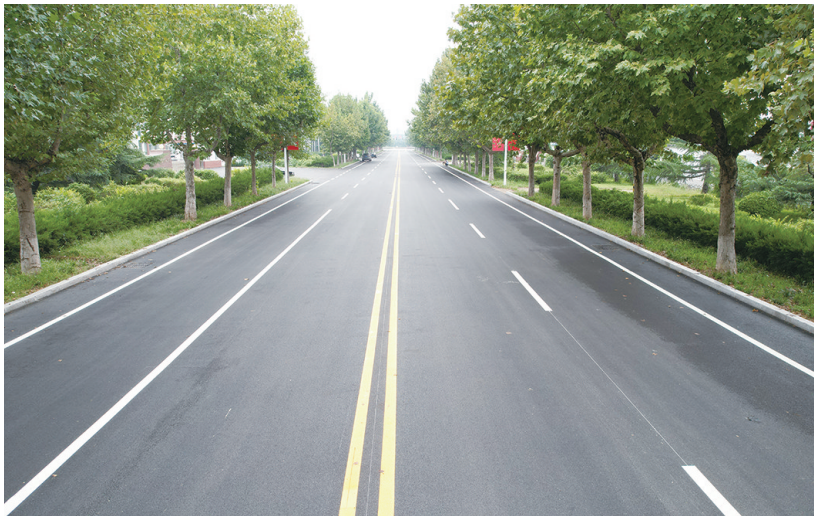
■园区路改造升级,面貌焕然一新。
