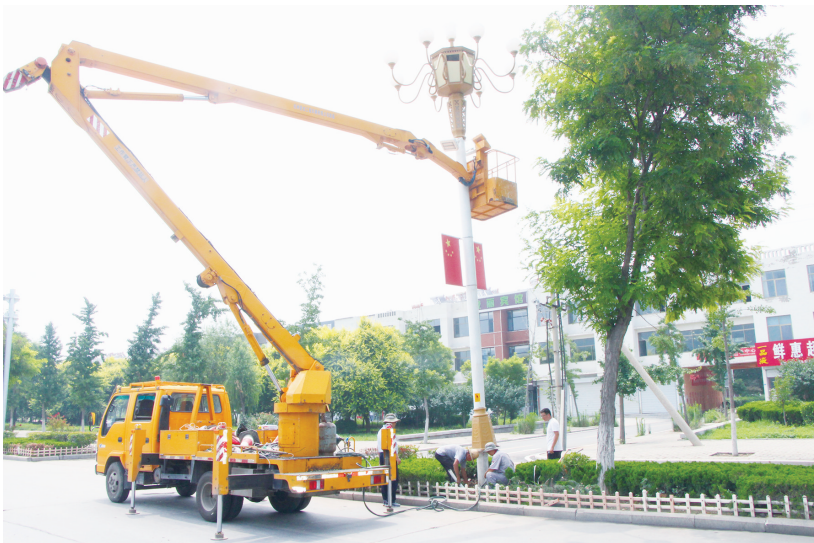
■对城区路灯进行维修。 通讯员 徐广杰 摄
