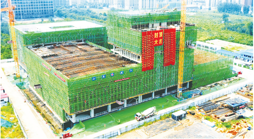
■宝来利来生物产业园1号车间封顶。
