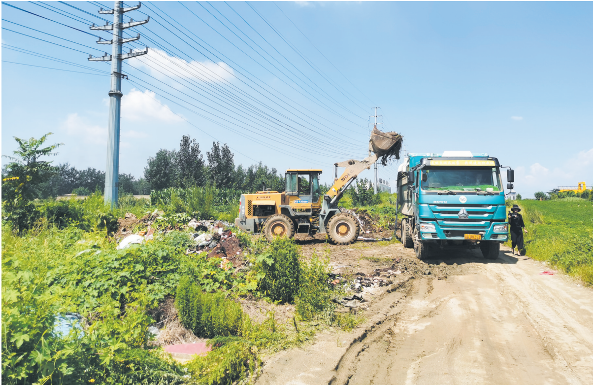
■山东能源重装集团南侧路上,工程车辆正在清理建筑垃圾。
