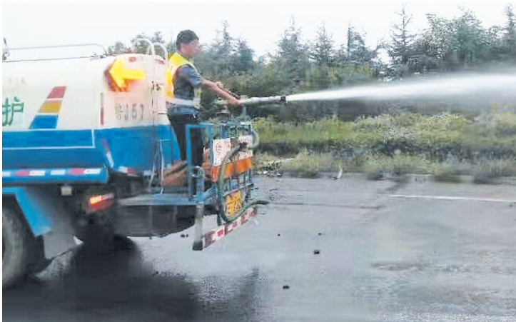
■使用洒水车对路面进行全面冲洗。 通讯员供图
