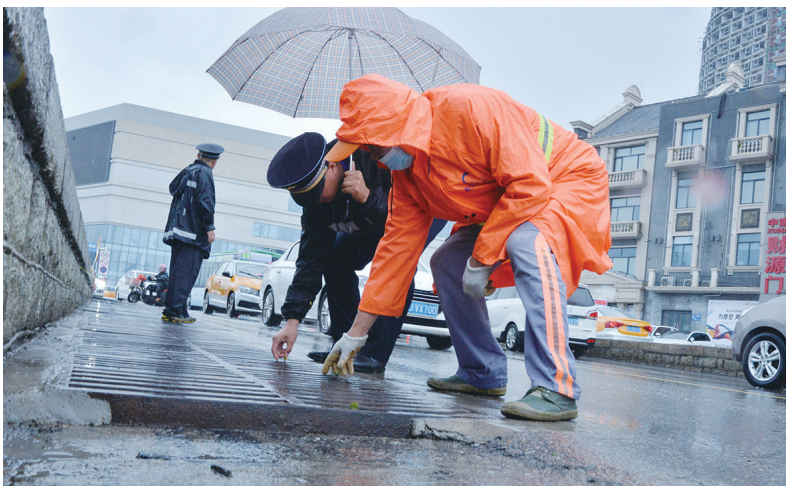
■为保证火车站桥下排水通畅,城管防汛人员实行24小时值守,随时清理地面积水。
