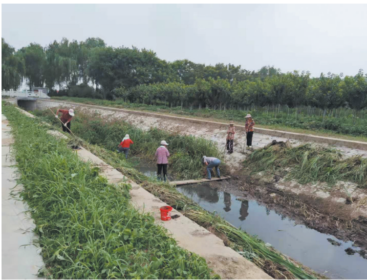
■工人正在进行河道清理。
