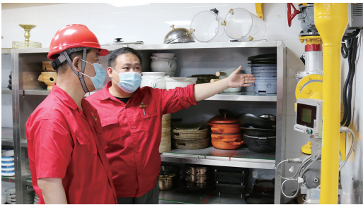
为工商户排查安全隐患。
