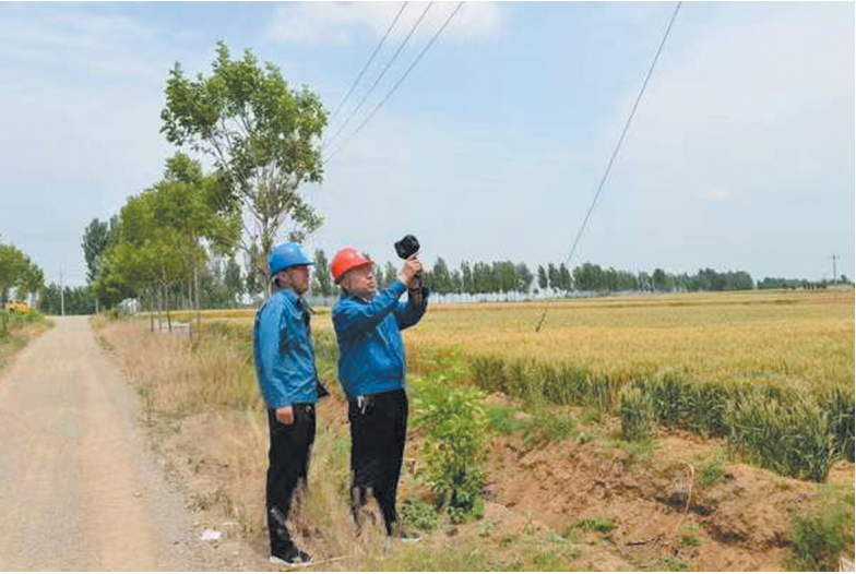
陈国宏(右)巡线过程中在测量配电设备温度 通讯员供图
