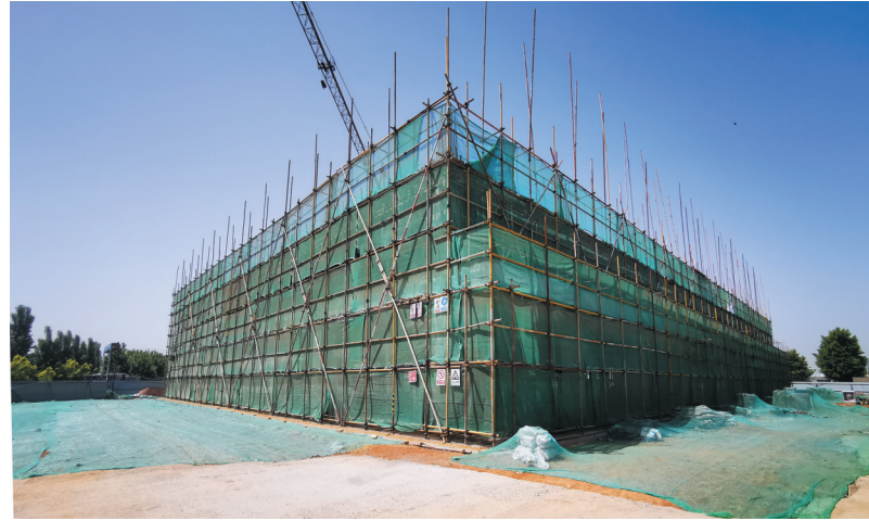
■鹤山镇养老服务中心项目建设中。
