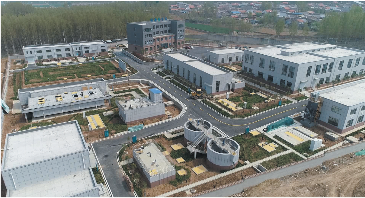
■入选市、县重点项目库的直界水厂项目。
