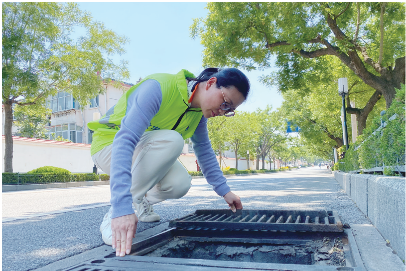
信息员对城市基础设施开展汛前安全隐患专项排查。 通讯员供图
