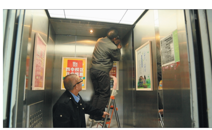
工作人员更换电梯监控设备。 最泰安全媒体记者 张亢 摄
