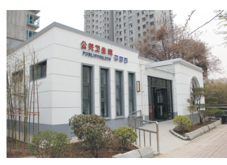
■新建公厕。最泰安安全媒体记者 李腾腾 摄
