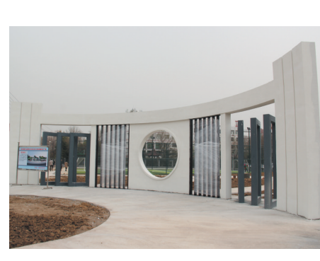
■金阳大街与杏岗路交叉口绿地。 最泰安安全媒体记者 李腾腾 摄
