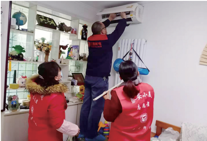
■志愿者入户为居民清洗空调。 通讯员供图
