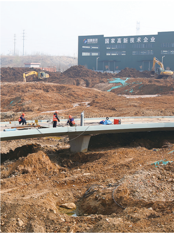
泰山区域山水林田湖草生态保护修复工程项目工地，工人们以饱满的热情投入到施工建设中。
