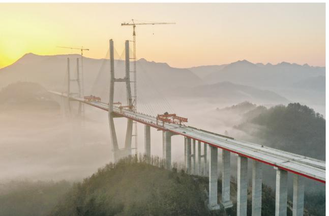
1月18日拍摄的贵州都安高速公路云雾大桥(无人机照片)。当日,贵州桥梁集团承建的都(匀)安(顺)高速公路云雾大桥成功合龙。云雾大桥位于贵州省贵定县云雾镇境内,全长1720米,两座索塔设计为折“H”型钢筋混凝土结构,高度分别为273米和300米,是都安高速公路控制性工程。 新华社发
