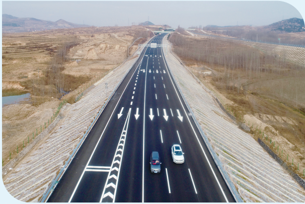
京沪高速改扩建竣工。
