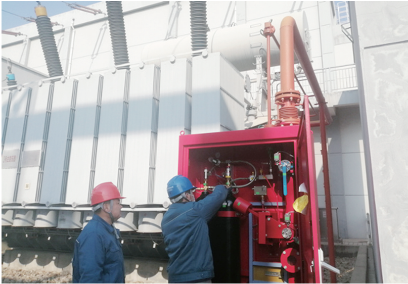
■电力工人逐一检修排查安全隐患。 通讯员供图
