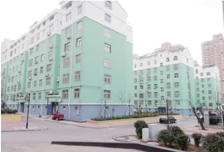
■改造后的外墙,保温效果和颜值均有提升。 通讯员供图
